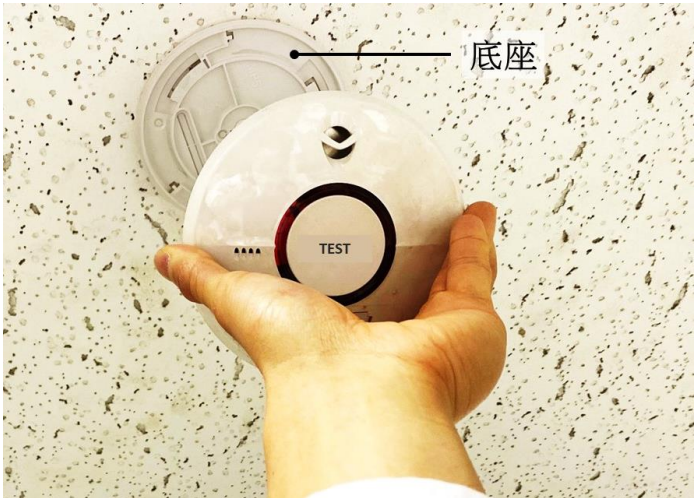
图 3—把独立火警侦测器装在底座上
